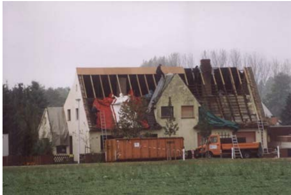
Haussanierung nach städtischem Förderprogramm
